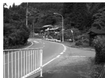
この先は歩道が設置できない
